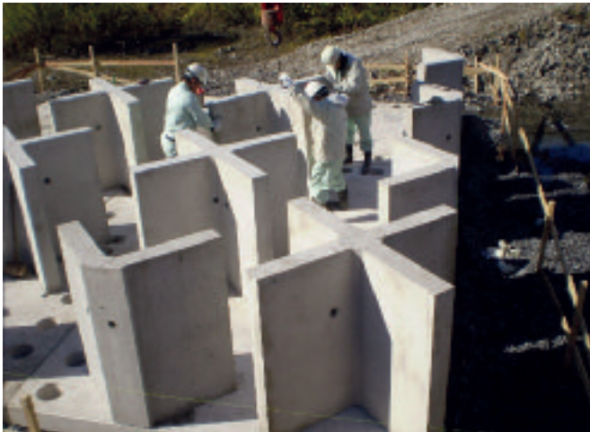
5, 6. Zbiornik retencyjny z elementów o przekroju w kształcie litery „X”.
