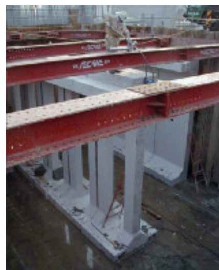
4. Sposób łączenia elementów na placu budowy. Elementy o przekroju w kształcie litery „I” są sprężane kablami, co gwarantuje odporność konstrukcji na trzęsienia ziemi.
